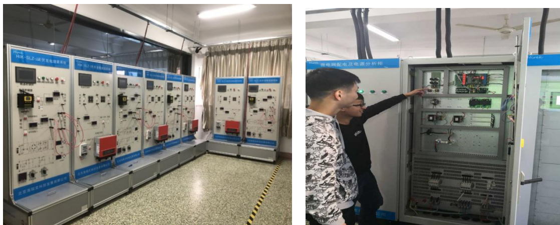
图 46 微电网运行与控制实训室
